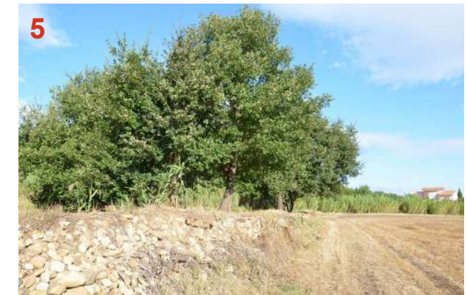
5 Talus instable comprenant quelques beaux sujets de chênes verts, à stabiliser par un aménagement paysager
