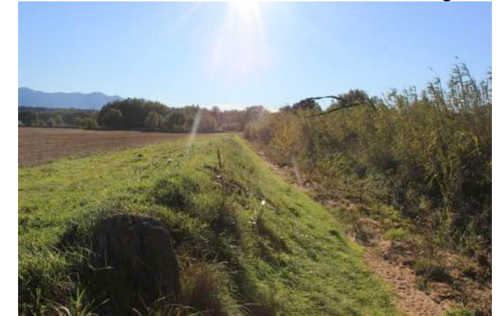
Fossé situé en limite du lotissement La Fabrègue
