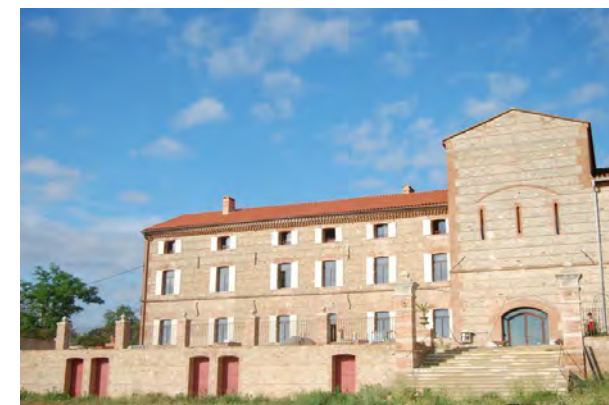
Vue nord-est depuis l'Agulle de la Mar. ▼
