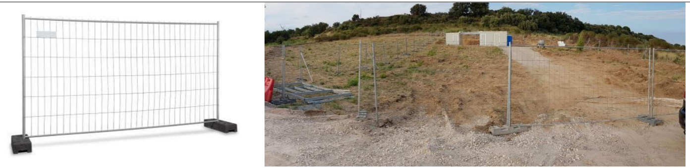
Figures 15 : Exemple de clôture mobile pour le balisage de l'aire de chantier
